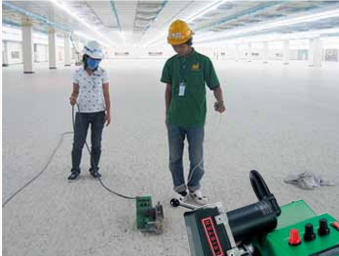
使用UNIFLOOR进行焊接约1公里长的焊缝，保证了同一水平的焊接质量。
