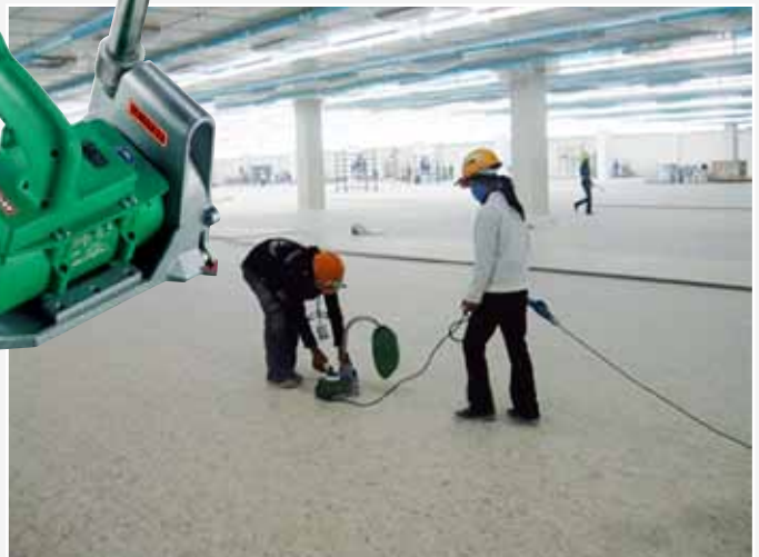
开槽设备GROOVER在使用过程中
