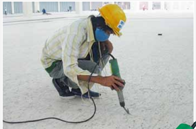
使用手动焊枪TRIAC S配合合适的风嘴进行细部焊接和处理
