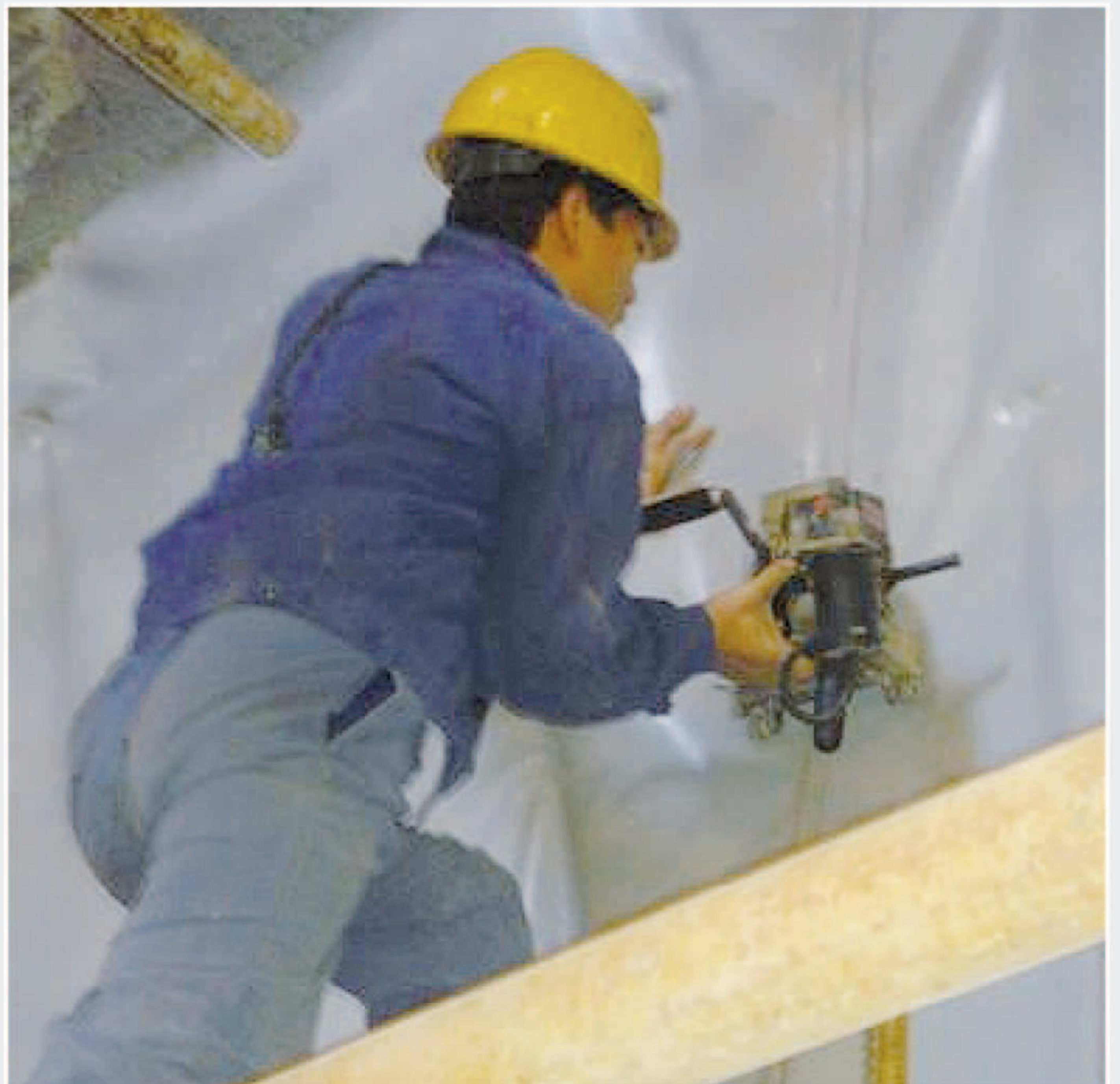
重量轻，携带方便的TWINNY S几乎可完全自己进行焊接。
