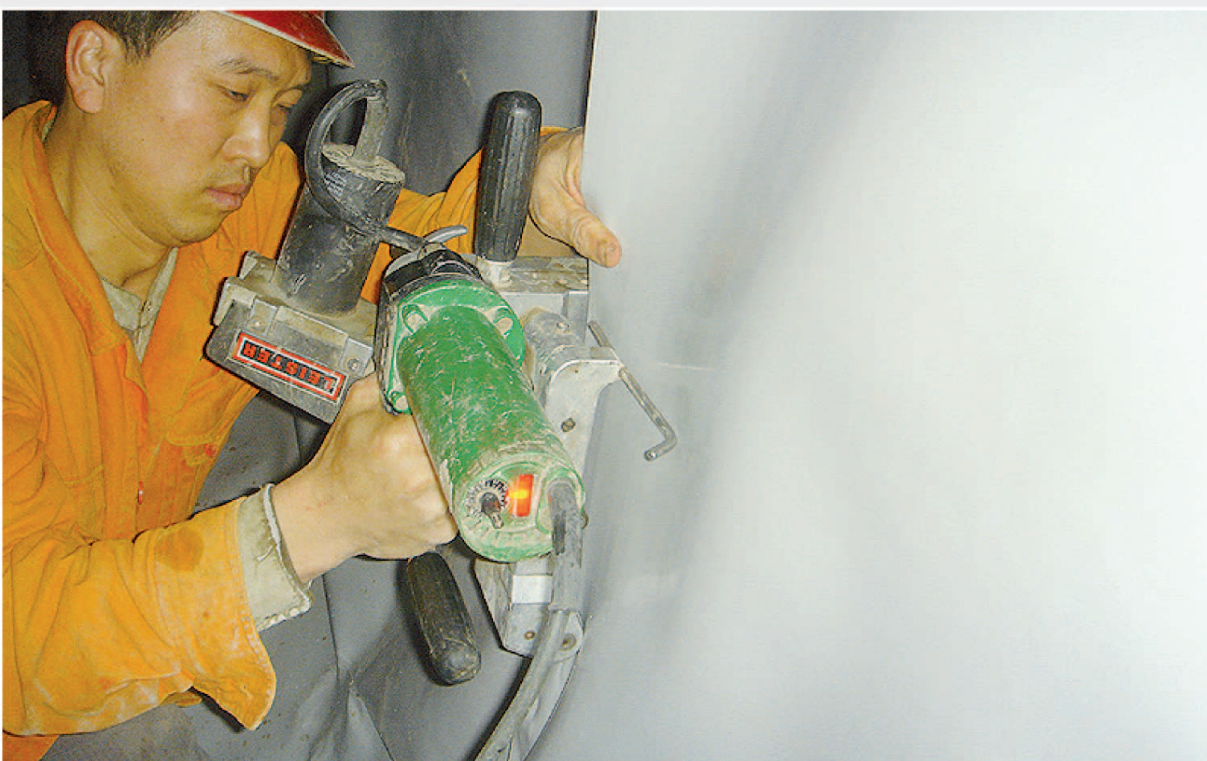
…可以非常容易地进行垂直方向的焊接。
