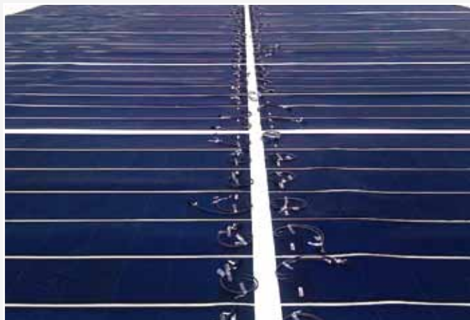
2000 多个太阳能电池片焊接在普洛斯公司七个物流仓库的屋面上。
