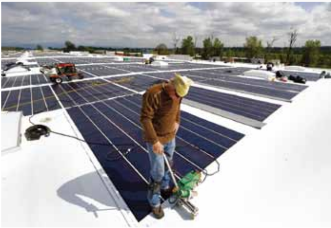
一家普洛斯物流仓库的太阳能屋面正在使用莱丹公司专业的焊接设备进行施工
