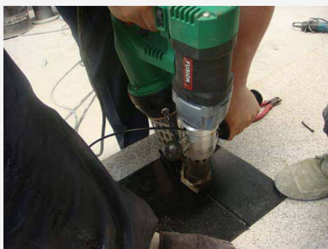
用FUSION2试焊接HDPE材料以确定合理的焊接工艺参数。
