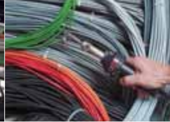
Anbringen einer Löt schrumpfung mit HOT JET S und aufgeschobenem Siebreflektor.
