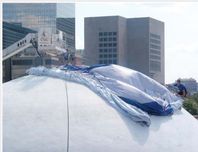
Ausrollen der riesigen Plane auf der Kuppel.
