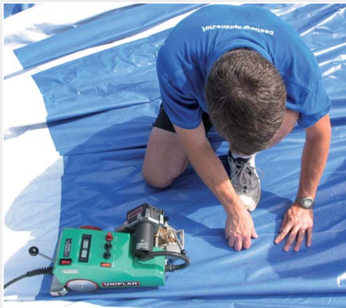
Verbinden der Viertelstücke mit dem UNIPLAN E.
