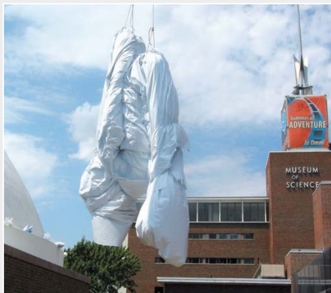
Hochhieven des ganzen Teils vom Flachdach auf die Kuppel.
