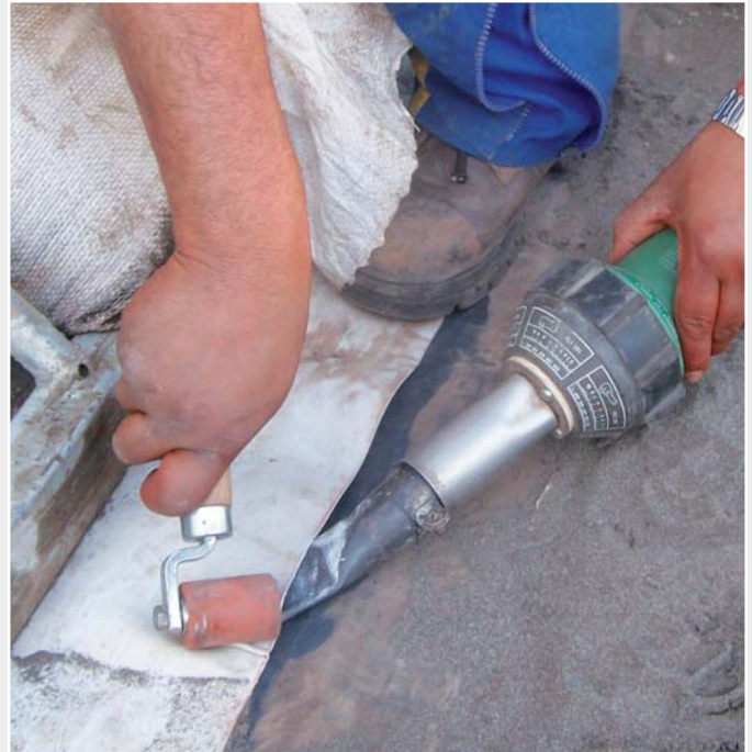
Das bewährte Handschweissgerät TRIAC S für Detailarbeiten.
