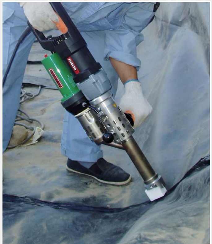
Der Hand-Extruder FUSION 3 für ermüdungsfreies, aufrechtes Extrusionsschweissen.
