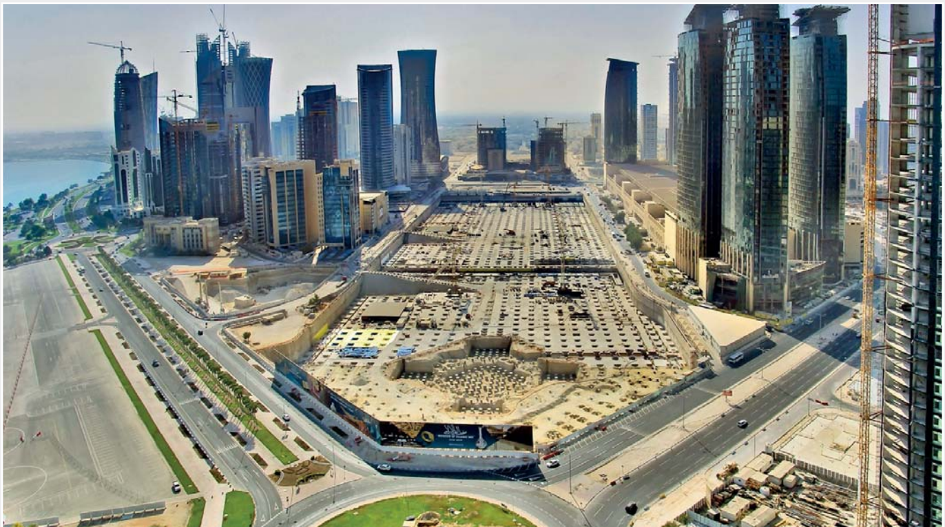
Überblick auf das Baugelände des Convention Centre.
