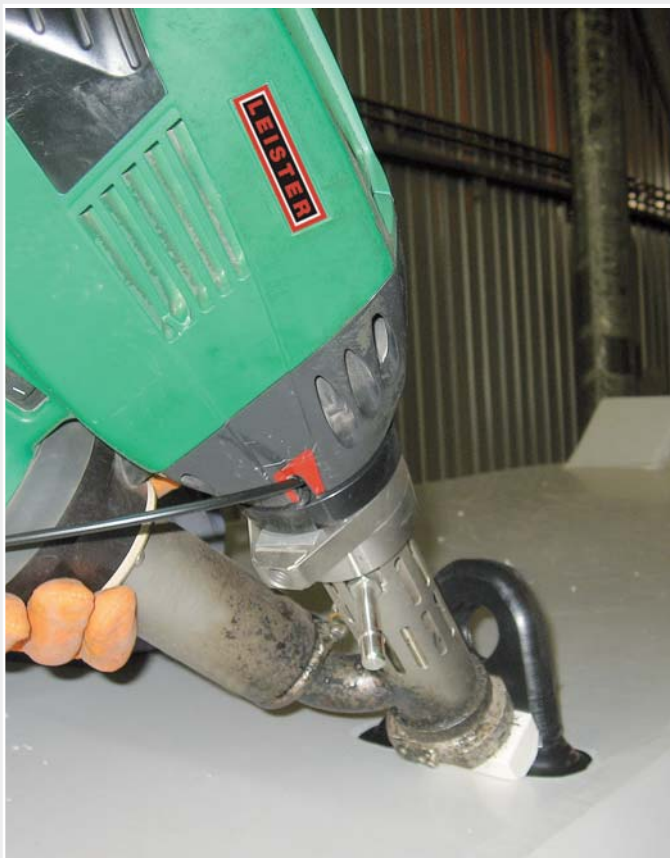
WELDPLAST S2 beim Einsatz an einem heiklen Detail.
