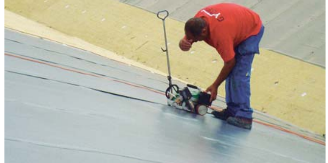
Der UNIROOF E klettert selbst steile Dächer hoch.
