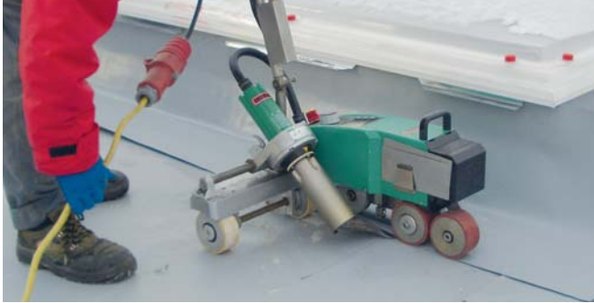
Durch seine schlanke Bauweise ist selbst randnahes Schweißen möglich.
