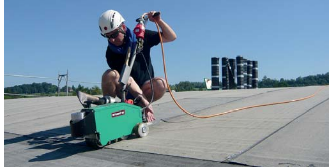
Der BITUMAT B2 schweisst Elastomerbitumen flammenlos.
