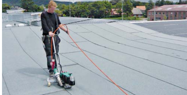
Einfache Geräteführung und sauberes Arbeiten mit dem BITUMAT B2.
