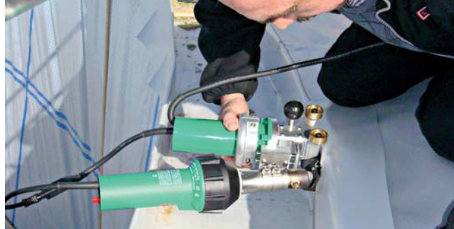
Selbst horizontal lässt sich mit dem TRIAC DRIVE PID schweißen.
