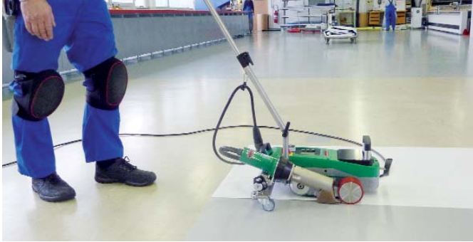
Konstante, faltenfreie Überlappschweißungen.
