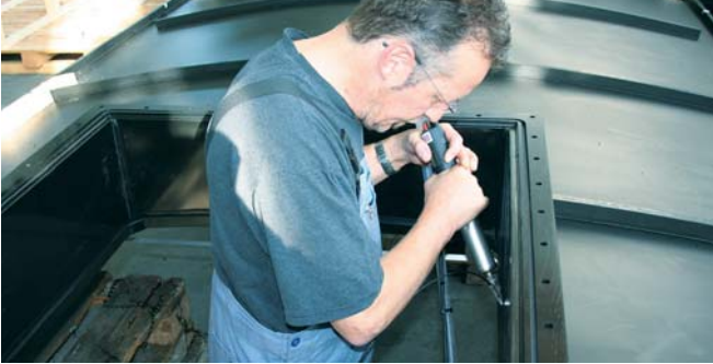
DIODE PID beim Ziehschweißen an einem PE-Behälter.
