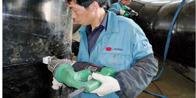
Der FUSION 2 beim Einsatz im Behälterbau in China.
