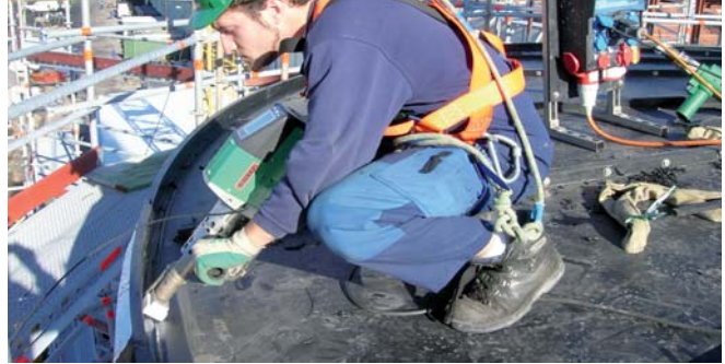
Der WELDPLAST S4 im Ausseneinsatz in Spanien.
