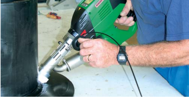
Der handliche WELDPLAST S2 im Einsatz.
