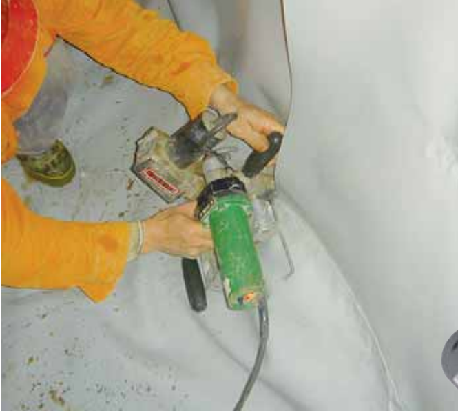
Der TWINNY S lässt sich auch bei engen Platzverhältnissen einfach einfahren.
