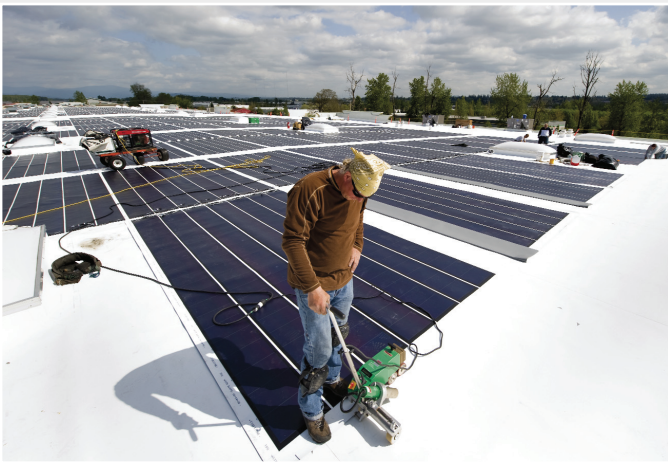
Zuverlässiger Leister Heissluft-Schweissautomat im Einsatz auf einem Flachdach von ProLogis.
