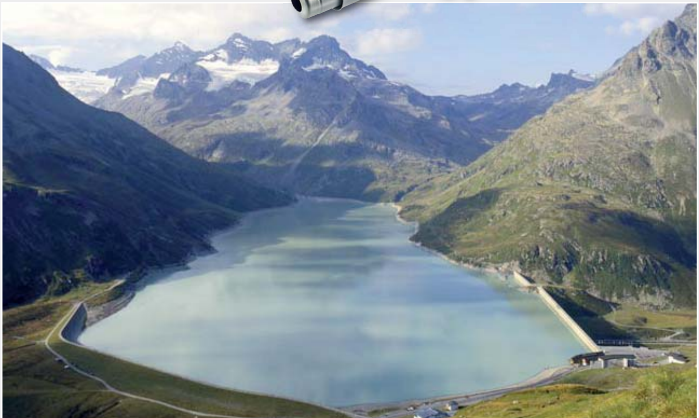
Der Silvretta-Stausee aus der Vogelperspektive. Unten rechts die 80 m hohe Hauptmauer, darüber die 31 m hohe Nebenmauer.
