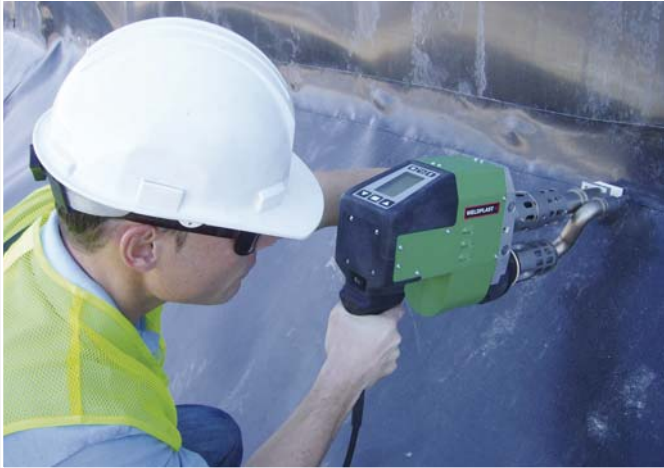
Der WELDPLAST S4 beim Verbinden der Kunststoffdichtungsbahnen an der Uferbordung.
