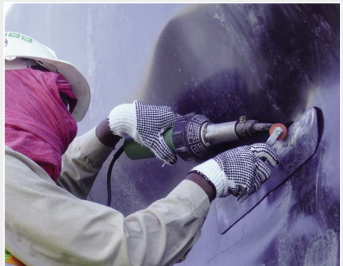
Der TRIAC wird in Dubai auch für das Heften von Kunststoffabdeckungen eingesetzt.
