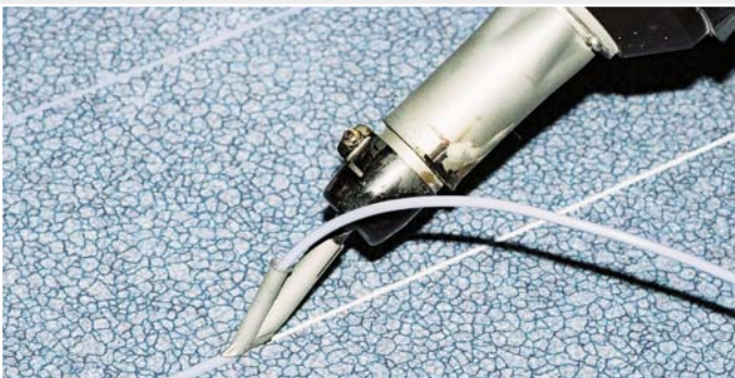
Buse de soudage rapide sur Leister TRIAC PID pour un travail précis.
