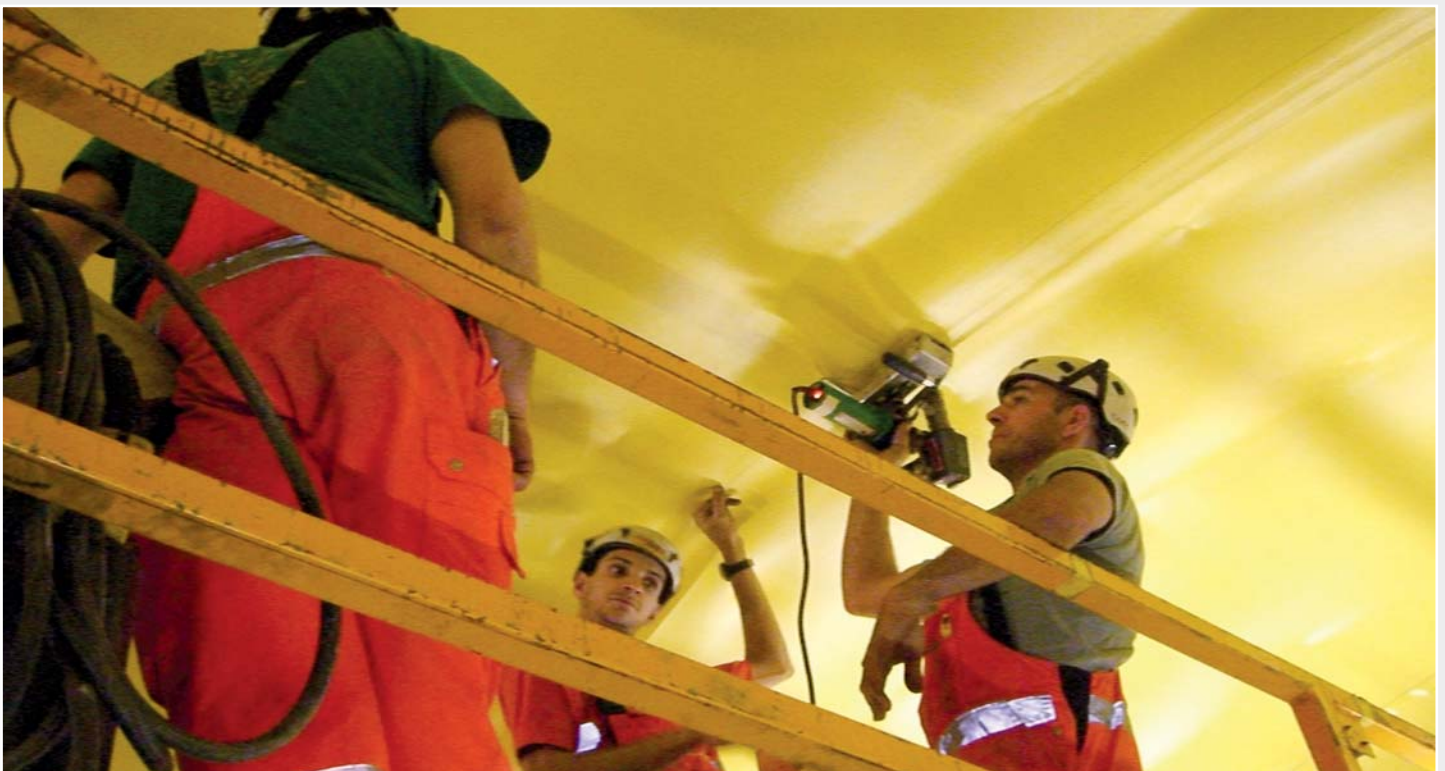
Travaux de soudage au plafond avec la TWINNY S.
