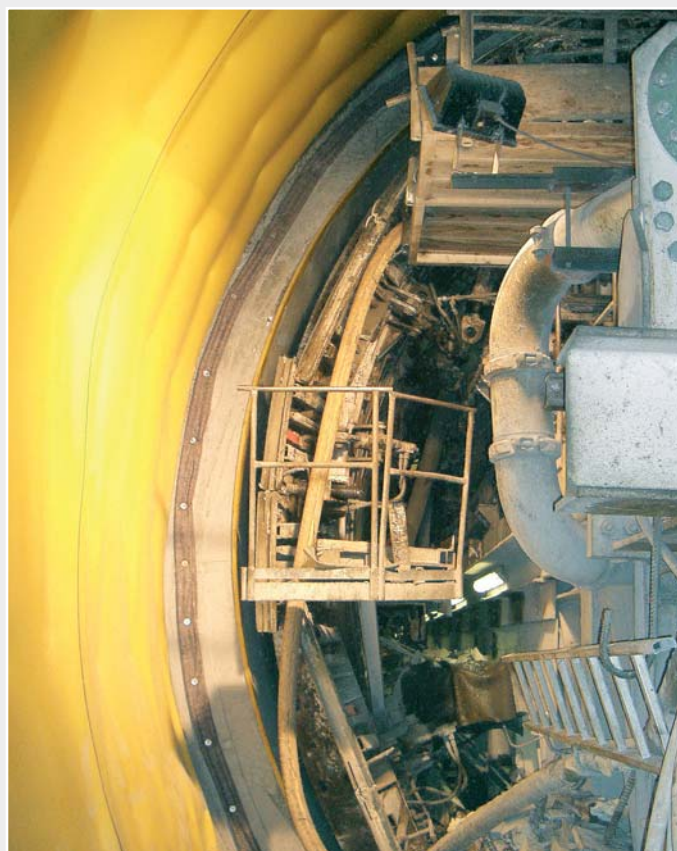
La couche d'étanchéité soudée finie avant le bétonnage de la coque intérieure du tunnel.
