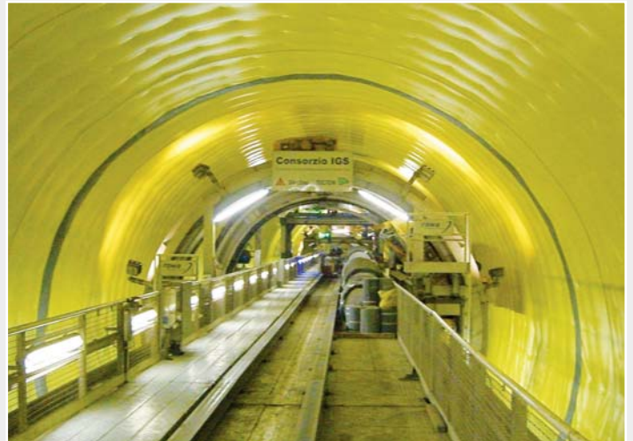
Etanchéité du tunnel terminée. Les revêtements sont soudés parallèlement.
