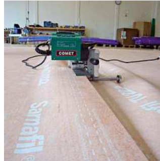
Soudage confortable grâce aux systèmes de guidage.
