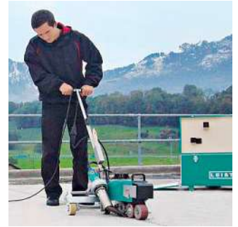
La nouvelle VARIMAT V2 à l'œuvre. Elle a été hissée directement sur le toit dans le boîtier d'appareil pratique.
