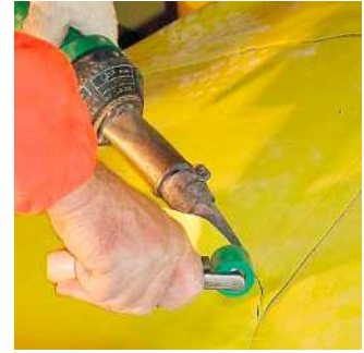
Le rouleau de pression, un accessoire indispensable dans les tunnels.
