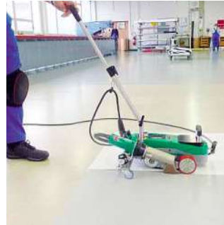
Soudures par recouvrement homogènes et sans pli.
