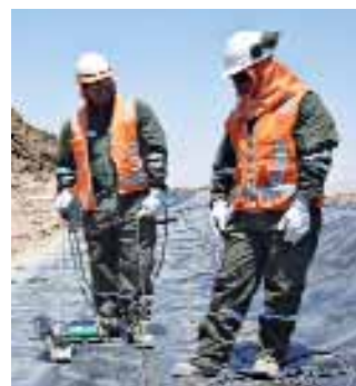
TWINNY S avec panne combinée pour des soudures dans une mine d'Amérique du sud.
