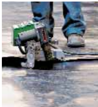
TWINNY T avec panne combinée pour le soudage d'un revêtement d'étanchéité en HD-PE.
