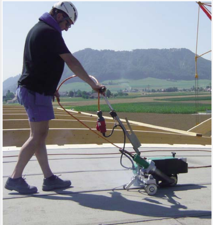
Guidage simple de l'appareil et travail propre avec la BITUMAT B2.
