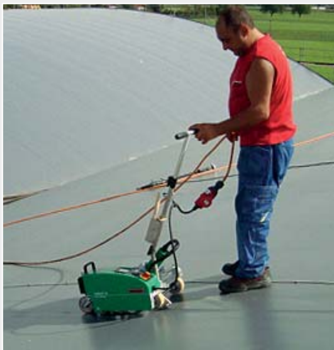
Le VARIMAT V2 – pour un soudage du revêtement d'étanchéité plus rapide.
