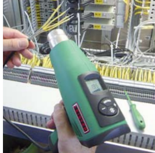
Termoretrazione di marcature per cavi.
