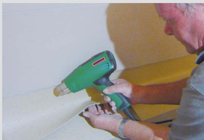
Per sagomare più rapidamente coperture per pavimenti
