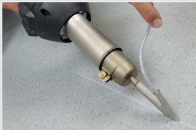
Pavimentazioni in materiale plastico e linoleum
