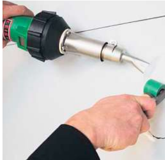
La saldatura di toppe con TRIAC PID in cantiere.
