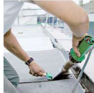
Il potente ELECTRON dotato di ugello a fessura larga per la saldatura di guaine bituminose.
