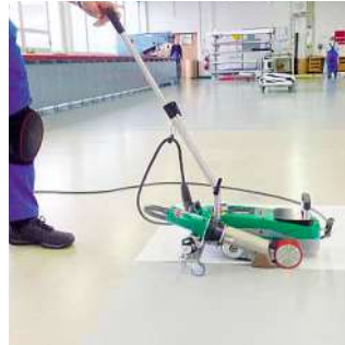
Saldature a sovrapposizione uniformi senza pieghe.
