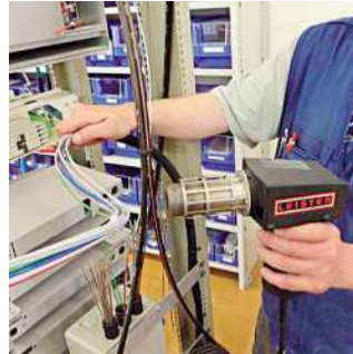
Riscaldamento dei fasci di fibre ottiche per semplificare le lavorazioni.
