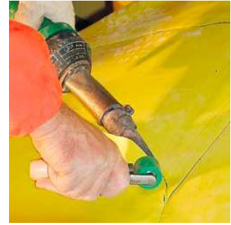
Rullo pressore come accessorio indispensabile nei tunnel.
