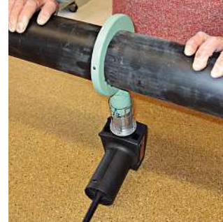
パイプの溶接
