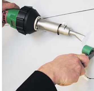
建設現場でのトリアックPIDによるパッチ溶接
