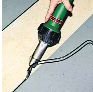
スピード溶接ノズルを装着したトリアックSをリノリウムの溶接に使用中
