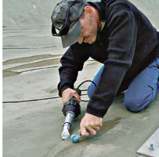
トリアックPIDに平型ノズルを装着して、コネクタを溶接
