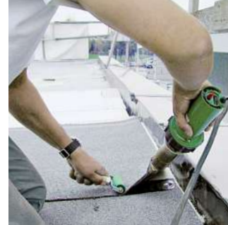
平型ノズル付きのエレクトロンを使用した アスファルトシートの溶接
