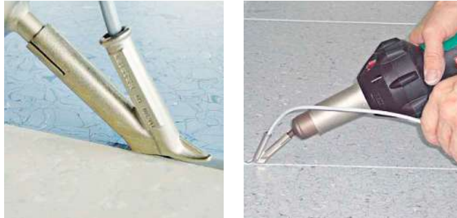
Para uma soldagem perfeita de revestimentos em pisos.
