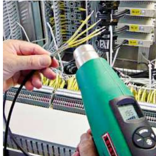
Encolhimento de etiquetas de cabos.
