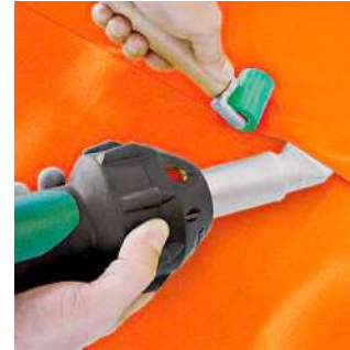
Perfeito para trabalhos nos telhados.
