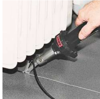
O HOT JET S adequa-se excelentemente para soldagem em locais de difícil acesso.
