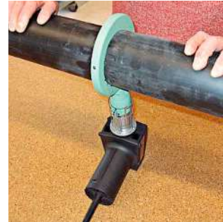
Soldagem de tubos com terminal espelho.
