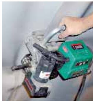
TWINNY T com uma alavanca transversal. Muito prática na hora da soldagem por cima da cabeça dentro de um túnel.
