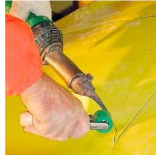
O rolo de pressão como acessório indispensável no túnel.
