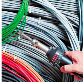
Aplicação da conexão de solda com HOT JET S e terminal refletor tipo concha.
