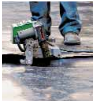
TWINNY T com cunha combinada na soldagem de uma cobertura de membranas HD-PE.
