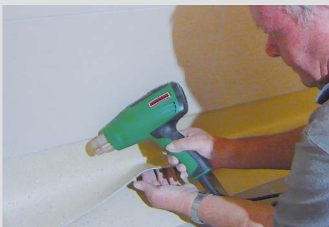
Błyskawiczne formowanie wykładziny podłogowej
