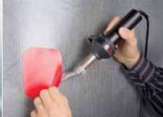
Sudura realizata cu HOT JET S
