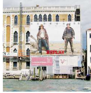
Mainosjulisteet hitsattu täsmällisesti.
