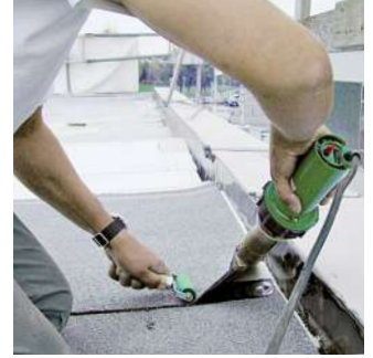
Bitumivuorauksen hitsaus tehokkaalla ELECTRON käsityökälulla, jossa on leveä rakosuutin.
