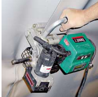
TWINNY T työssä mukavalla ristikädensijalla: ylöspäin hitsausta tunnelissa.
