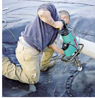
WELDPLAST S6 kalvon putkikauluksen hitsausta yhdyskuntarakennustyömaalla.
