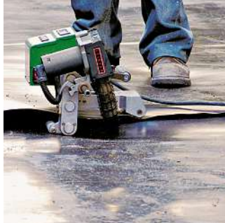
TWINNY T kombikiilalla, HD-PE tiivistyslevyn hitsausta.
