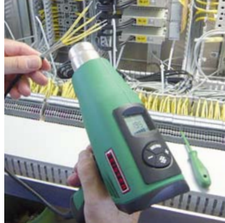
Retracción de etiquetados de cables
