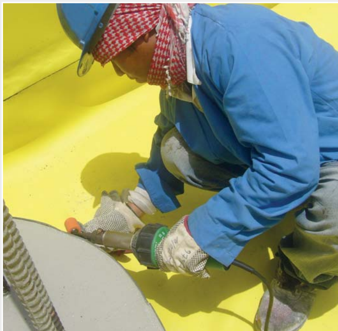
Soldadura en zonas de difícil acceso con la herramienta de aire caliente TRIAC S y rodillo de presión.
