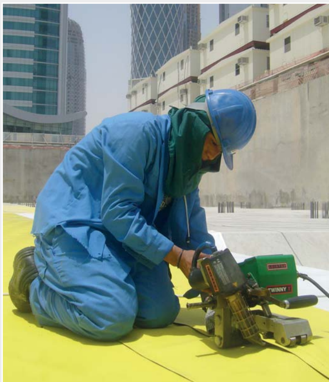
Máquina de soldadura TWINNY T soldando una costura de doble soldadura con canal de prueba.
