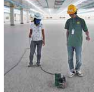
Soldaduras perfectas con la UNIFLOOR E (Vietnam).
