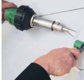
Soldadura de un parche con el TRIAC PID en una obra.
