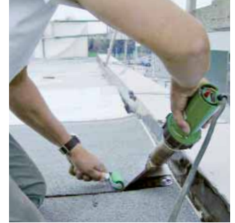
El potente ELECTRON con boquilla de ranura ancha soldando bandas de betún.
