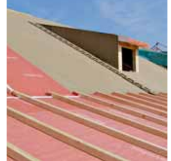
Resulta ideal para la soldadura de bandas en subtechos.
