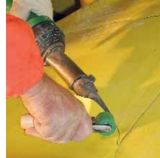
El rodillo de presión como accesorio imprescindible en el túnel.
