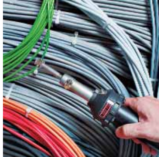
Instalación de una unión por retracción con el HOT JET S con reflector de tamiz acoplado.
