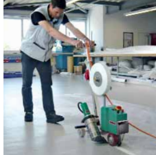
Soldadura de cintas a máxima velocidad.
