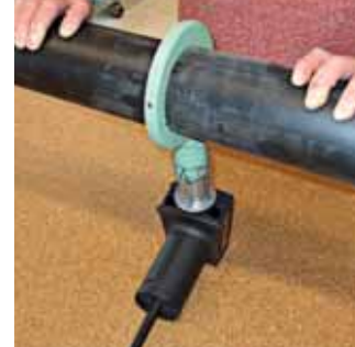
Soldadura de tubos por placa caliente.
