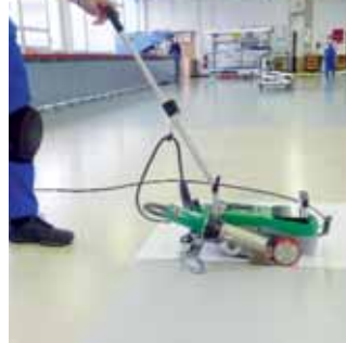
Soldadura a solape constante y sin pliegues.
