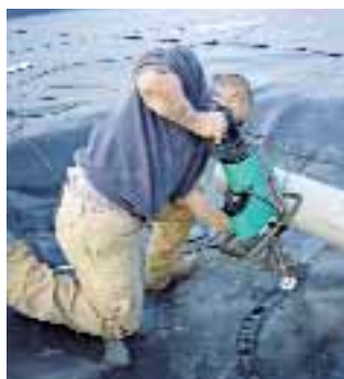
WELDPLAST S6 en el montaje de un vertedero.
