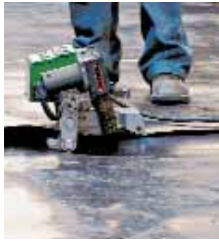
TWINNY T con cuña combinada soldando una banda impermeabilizante de PEAD
