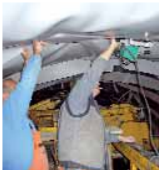
Trabajando con la COMET en un túnel ...
