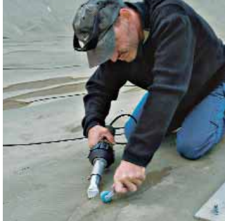
Soldadura de conexiones con el TRIAC PID y boquilla de ranura ancha.
