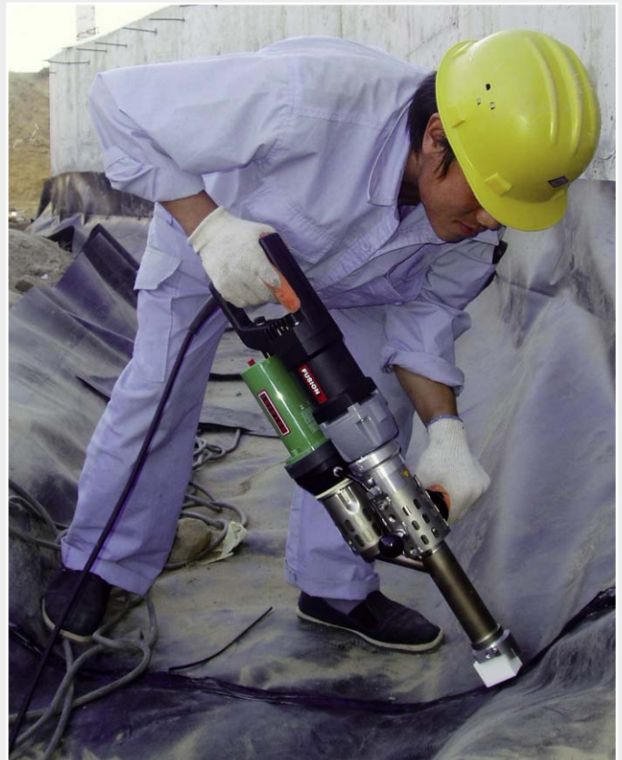
Extrusión de las láminas de sellado con la extrusora manual FUSION 3 en superficie subterránea irregular.
