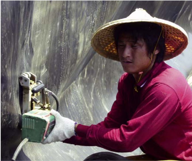
Soldadura del material de PEAD con el COMET en diques empinados.
